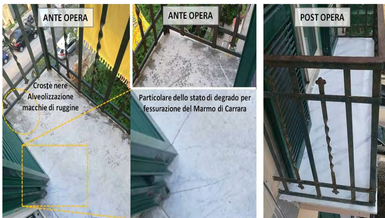
Fig. 4: Risanamento e costruzione di un balcone in Marmo di Carrara.
