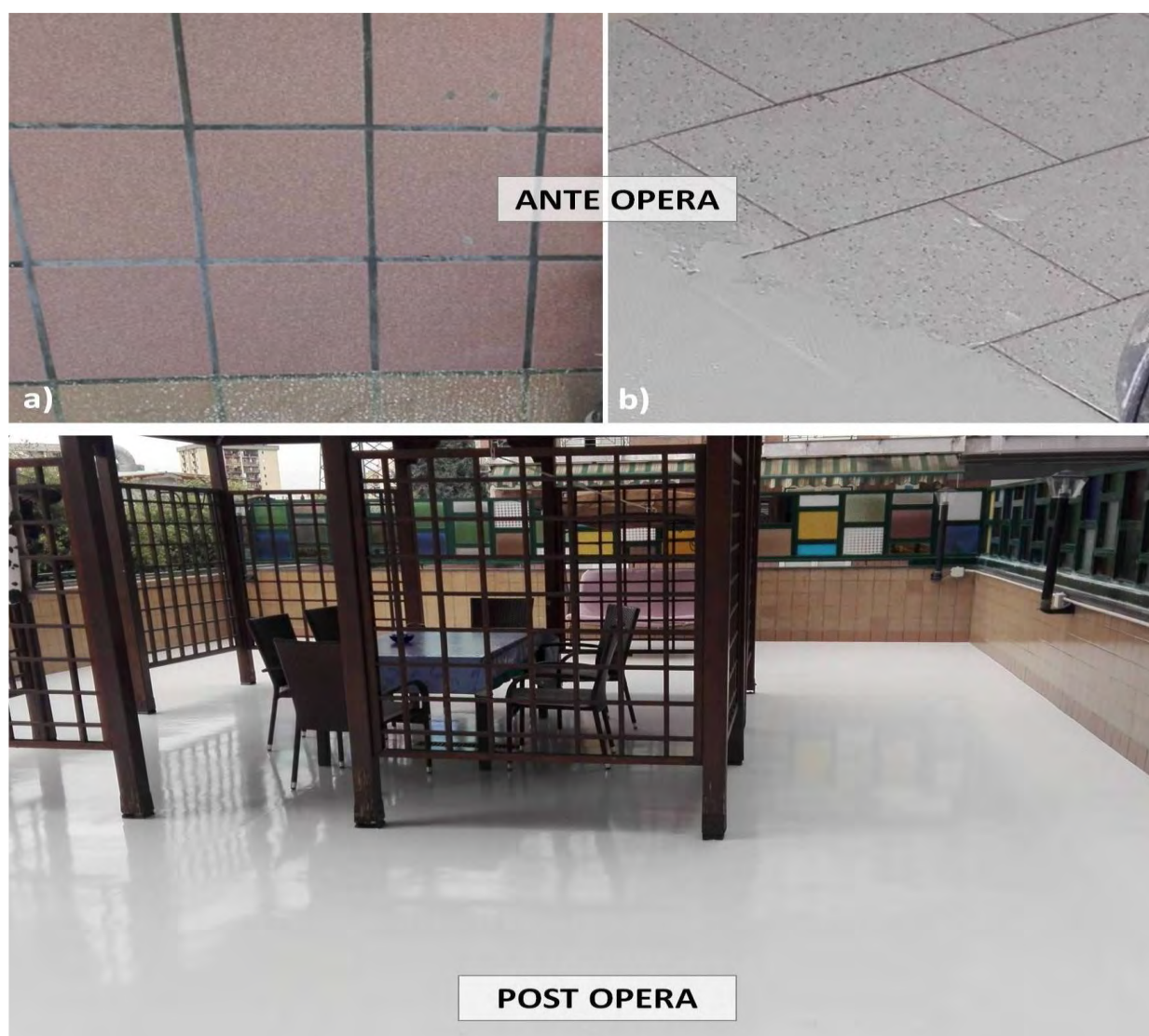
Fig. 6: a) Particolare del rivestimento preesistente (ante opera); b) Particolare della pavimentazione preesistente (ante opera); Foto in basso) visione complessiva post opera.
