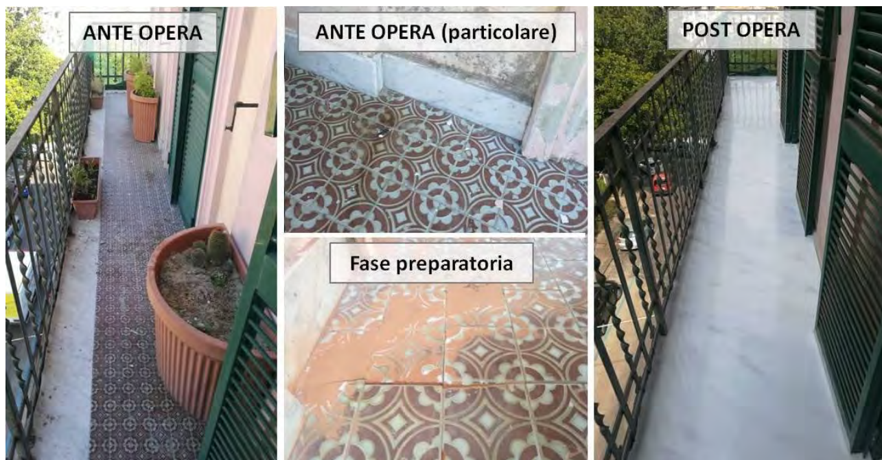
Fig. 3: Risanamento di un terrazzo in maiolica con Magmite Balco "venato".
