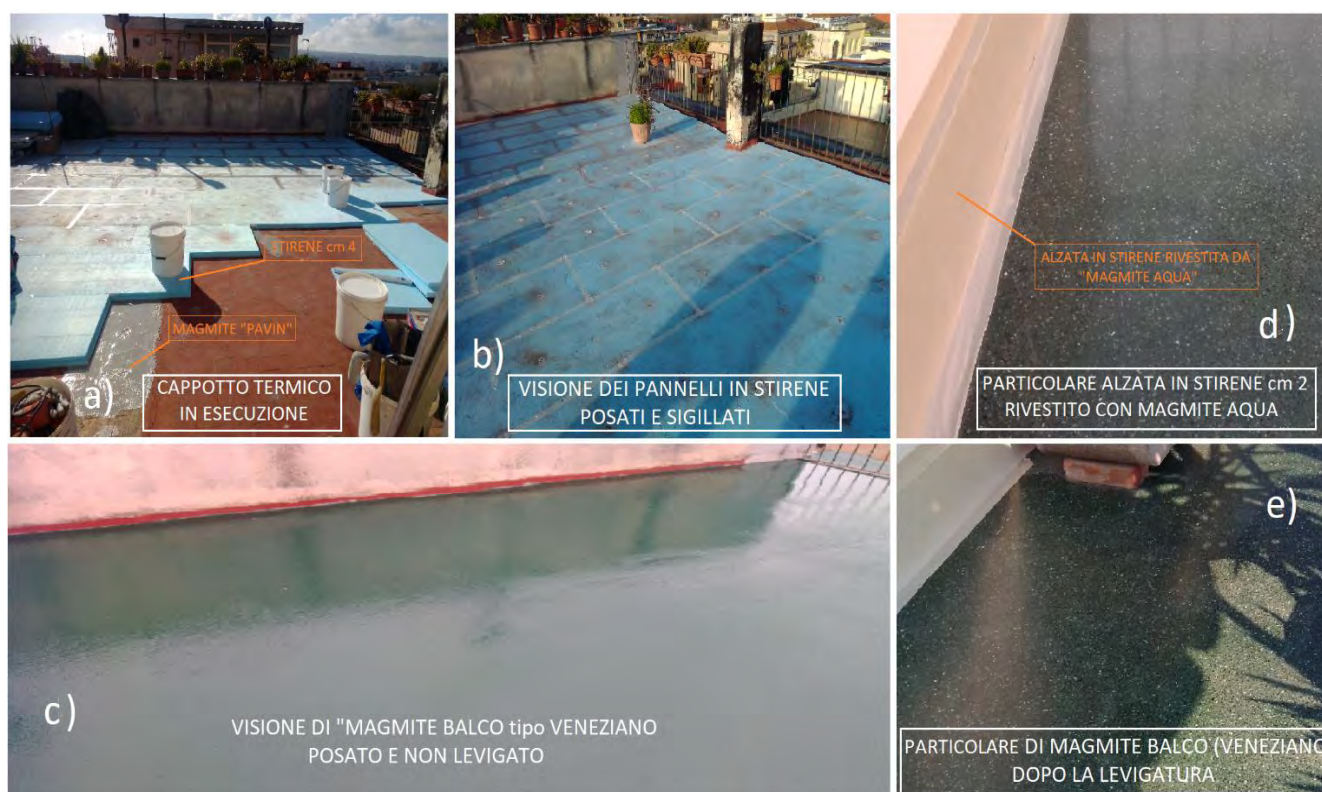
Fig. 7: a) Particolare dell'esecuzione del cappotto termico (in opera); b) Particolare del cappotto termico eseguito; c) visione della pavimentazione MAGMITE BALCO tipo VENEZIANO posata ma non levigata; d) alzata realizzata con stirene da cm 2 e rivestita con MAGMITE AQUA; e) pavimentazione MAGMITE BALCO tipo VENEZIANO dopo la levigatura e lucidatura a completamento dell' opera.
