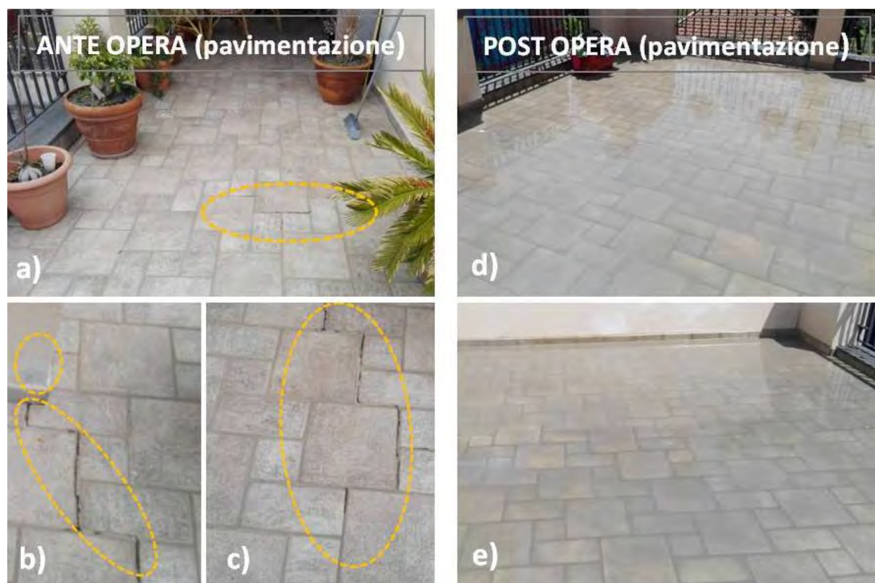
Fig. 1: a) visione del pavimento ante opera; b) e c) particolari delle fessurazioni del pavimento; d) e e) lavoro ultimato applicando MAGMITE BALCO TRASLUCENTE
