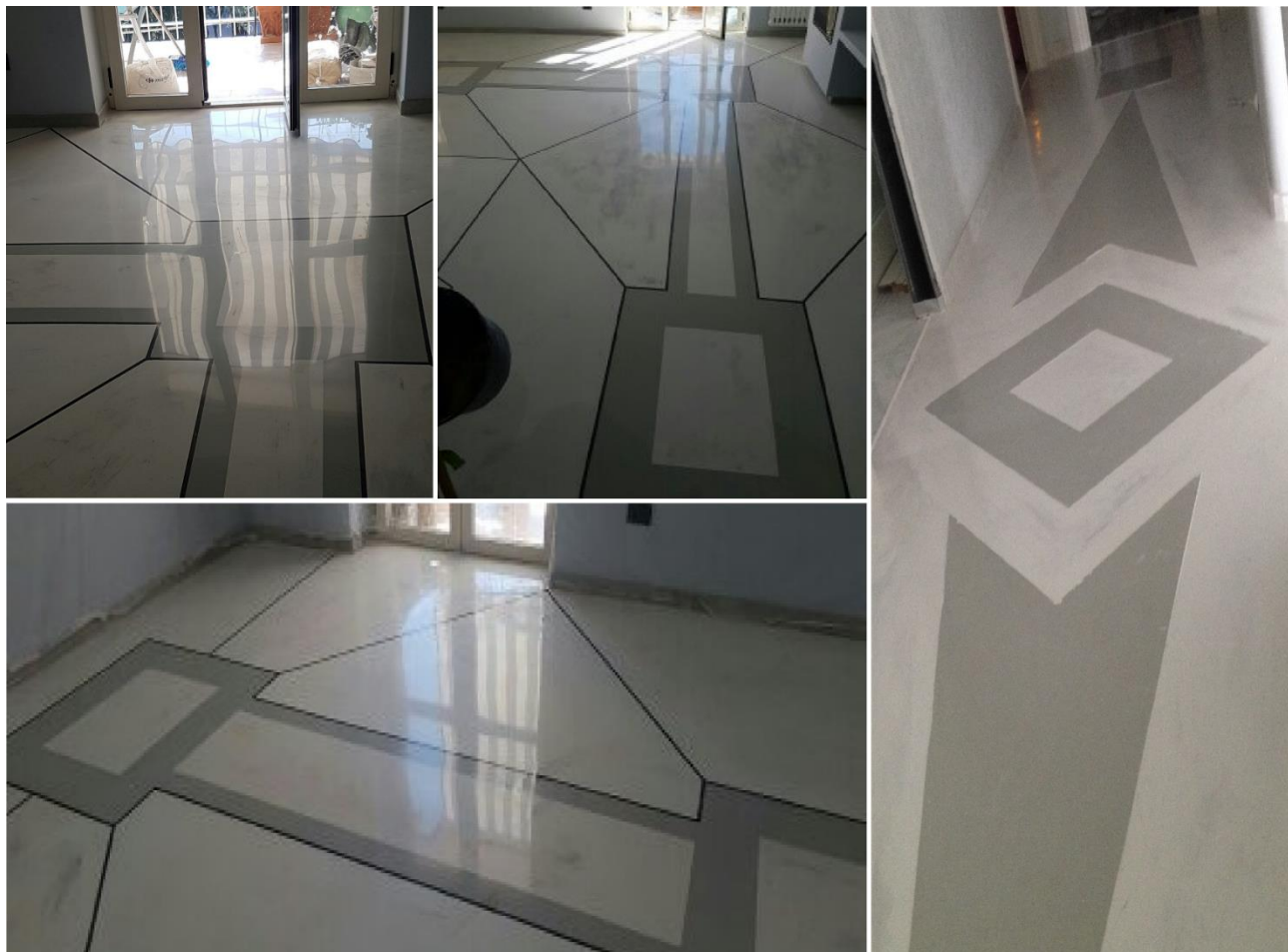
Fig. 6: Applicazione di MAGMITE PAV B disegnato e con effetto venato
