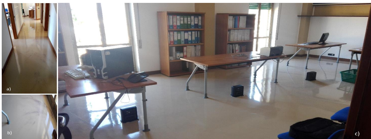
Fig. 7: a) visione del pavimento nell'area del corridoio; b) particolare delle sfumature del pavimento; c) visione del lavoro ultimato applicando MAGMITE PAV A con sfumature
