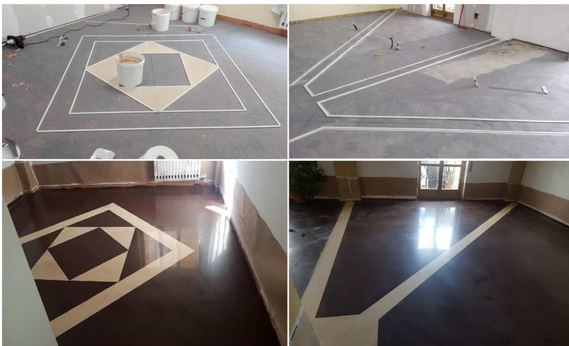
Fig. 8: FOTO IN ALTO: a) visione del pavimento ante opera e della preparazione dei disegni; FOTO IN BASSO: visione ad opera completata di "MAGMITE PAV A".
