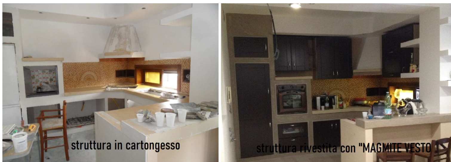
Cucina in muratura realizzata con cartongesso e "MAGMITE VESTO"
