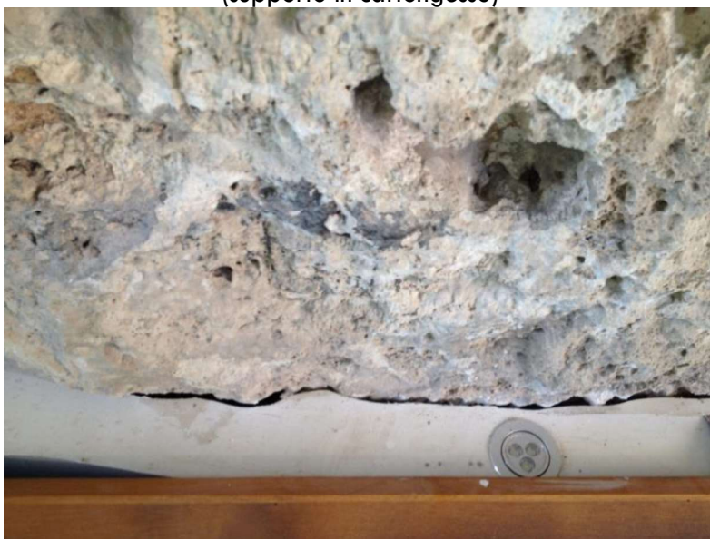
Vista prima dell' intervento (supporto in cartongesso)
